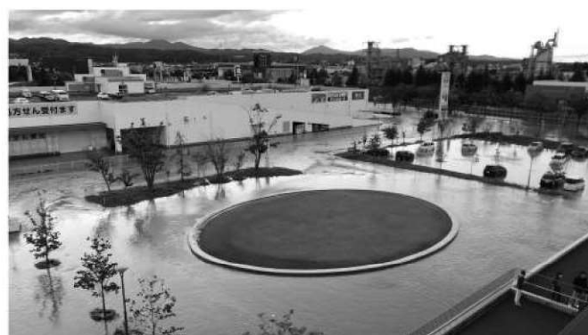
▲浸水した病院ロータリー
